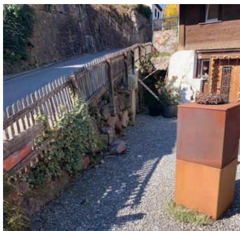
Sanierung Stützmauer Murgtalstrasse, Murg
