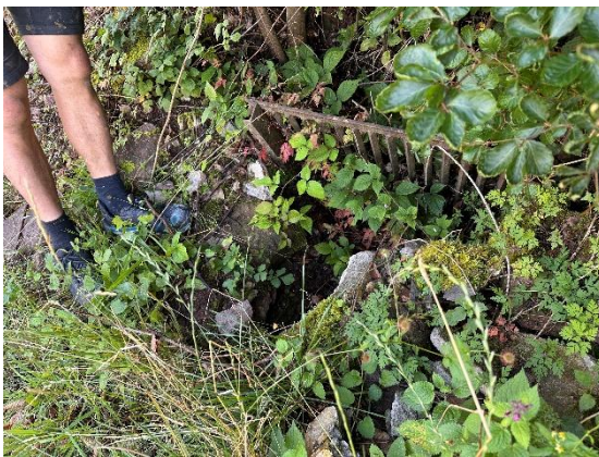
Abbildung 3: Einlaufrechen Quelle Ost, Blick gegen Fliessrichtung
