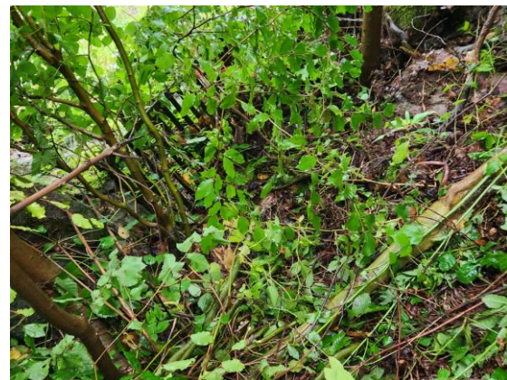
Abbildung 4: Einlaufrechen Quelle Ost, Blick in Fliessrichtung (Waldrand).
