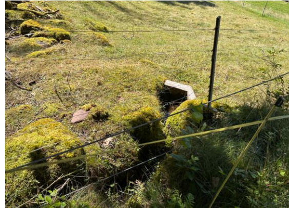
Abbildung 6: Offener Bachlauf, talseitig Quelle «West» und Einlaufbauwerk in nachfolgende Entwässerungsleitung.
