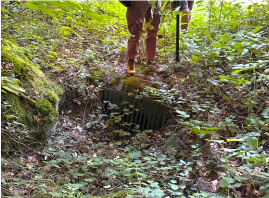
Abbildung 5: Einlaufbauwerk Quelle «West»
