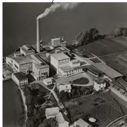
Seemühle Lochezen um 1920 1968 abgebrochen
