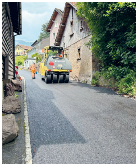
Sanierung Hofstettenstrasse Oberterzen
