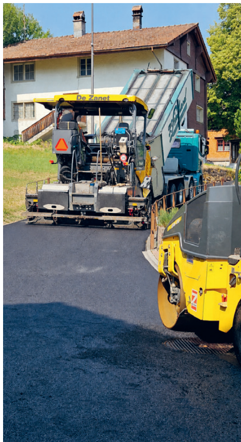
Sanierung Dorfstrasse, Quarten
